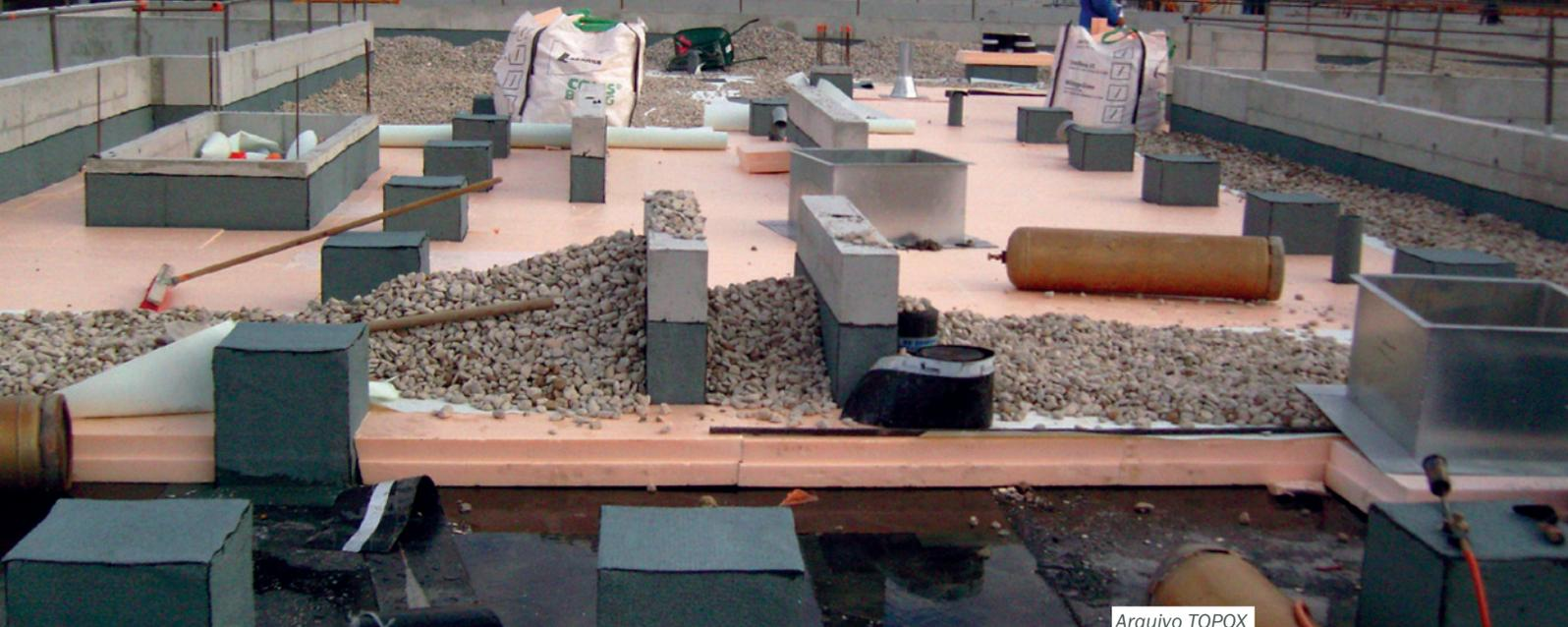
***Elevada resistência mecânica: Resistência à compressão entre 300 e 500 kPa.***
