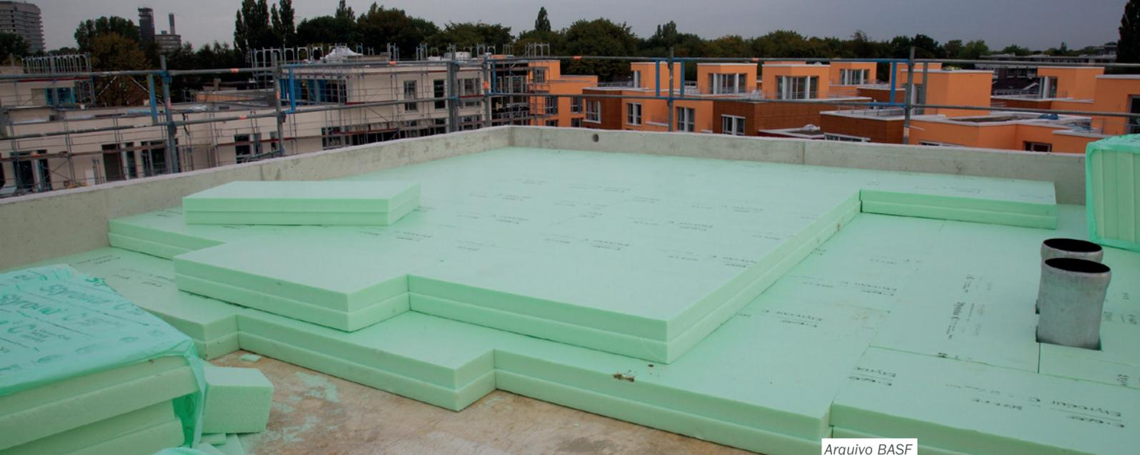
tópicos anteriores recomendam-se para a reabilitação de açoteias e coberturas planas, pela rapidez e simplicidade de execução e fácil acesso à camada isolante de XPS e à própria membrana impermeável para posteriores trabalhos de reparação e manutenção.
