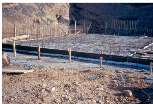
Foto 3: Solera terminada sobre aislante
