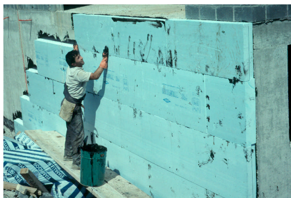
Foto 4: Aislamiento muro enterrado
