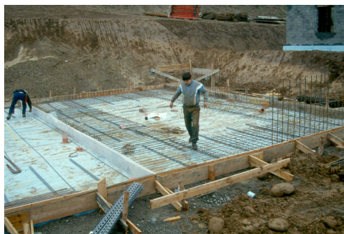
Foto 2: Instalación de las armaduras de la solera
