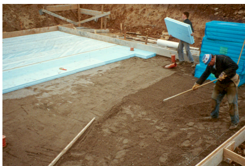
Foto 1: Aislamiento de la solera de cimentación
