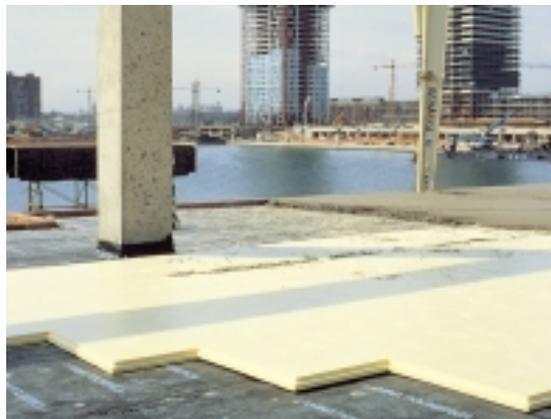
Se diferencia de la convencional en la posición del aislamiento térmico, que en este tipo de cubierta se sitúa sobre la membrana impermeabilizante.
