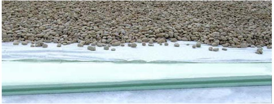
**Ejemplo de membrana monocapa no adherida**
