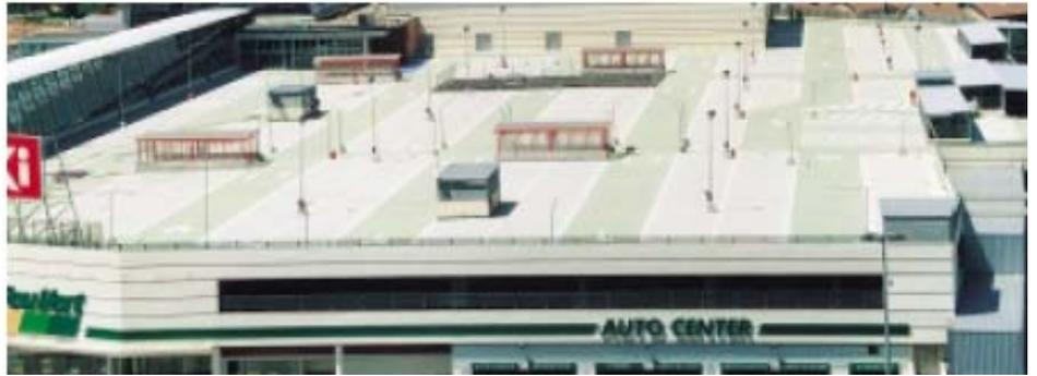
**Ejemplo de membrana bicapa adherida**
