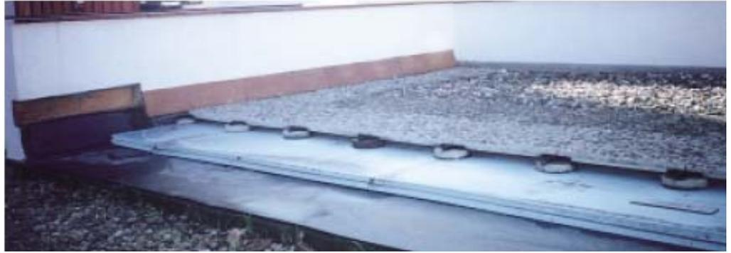
**Ejemplo de membrana bicapa adherida**
