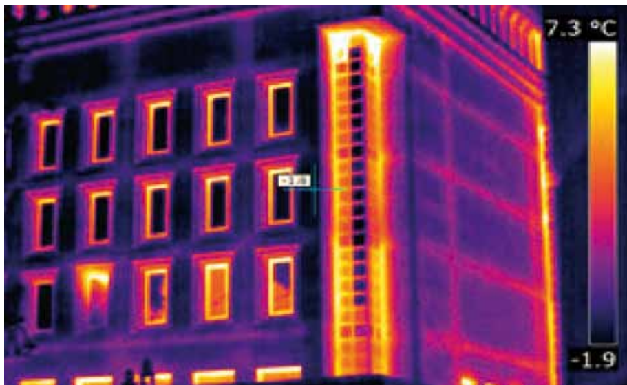
Foto termográfica de un edificio sin aislamiento con ETICS.
