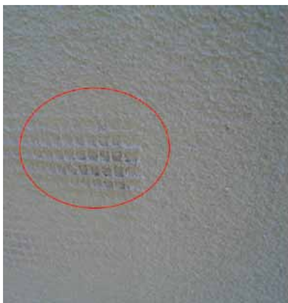
Defecto de aplicación de la segunda capa.
