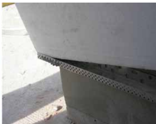
Aislamiento sobre el perfil de arranque.
