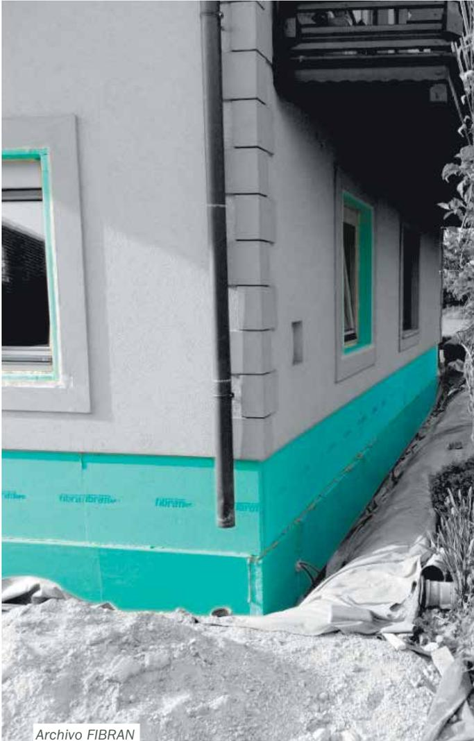
*En la unión del aislamiento en contacto con el terreno a la altura de la superficie del terreno con la capa de aislamiento de la pared exterior el zócalo produce, por norma general, un puente térmico.*
