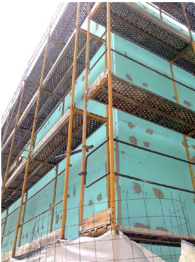
Fig. 3. Aplicación del sistema de aislamiento térmico por el exterior SATE con poliestireno extruido - XPS
