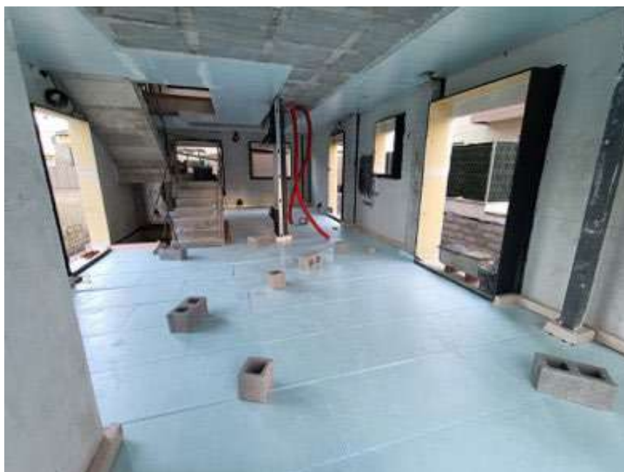
Fig. 5. Aislamiento térmico con poliestireno extruido de un suelo en contacto con espacio no habitable
